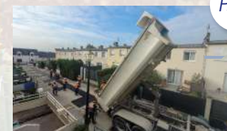
Travaux rues de Versailles - Verdun
