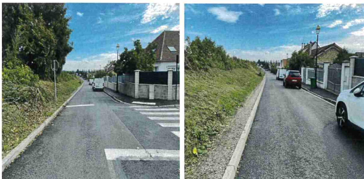
Elargissement de la voie sur la gauche
