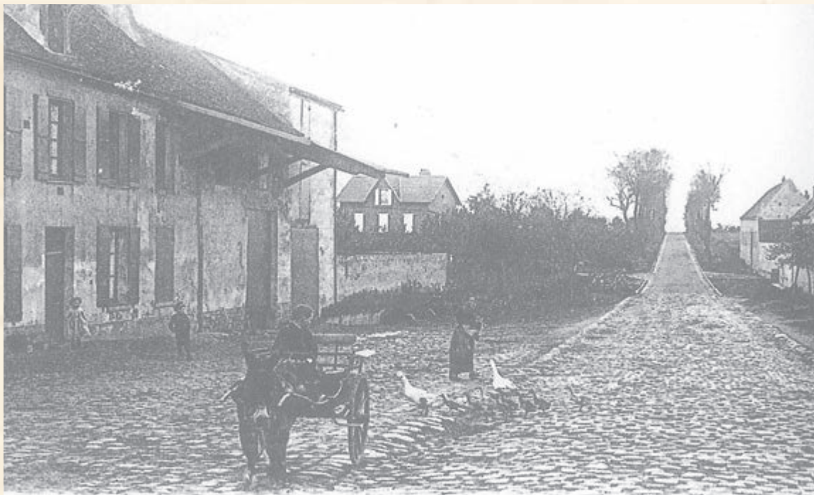
MAFFLIERS — Hameau de la Maison Neuve — Route Nationale
