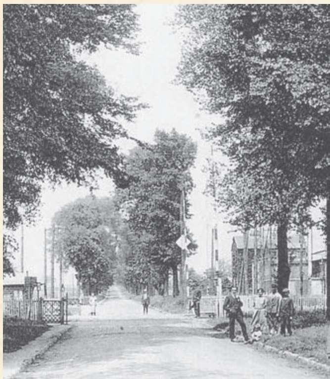
Le passage à niveau .....près de trente ans plus tard
